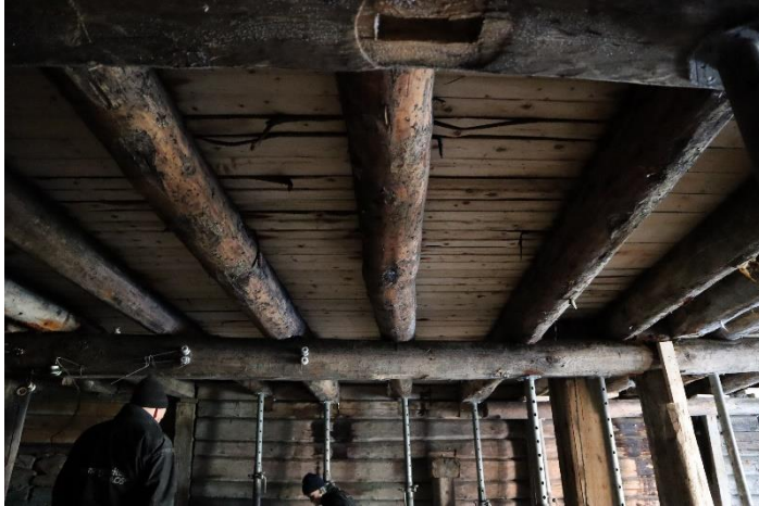
26. Sørbrygga. Reetablerer dragere og stolperække etter spor.
