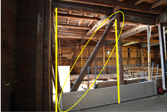
Midtbrygga. Strever yttervegg mot nord.
