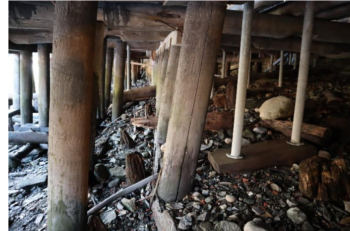
24. Sørbrygga. Sekundærbæring i øst/vest retning fjernes der den kommer i konflikt med bunnstokkene.
