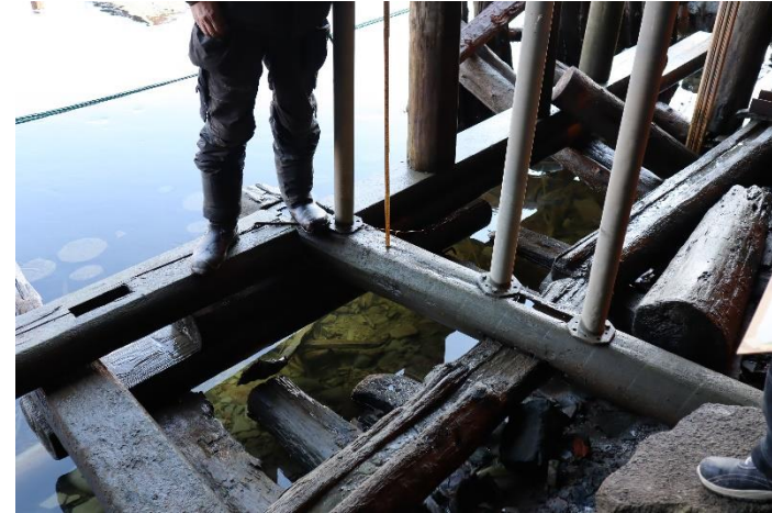
7. Nordbrygga. Nyere kreosotstokker fjernes.
