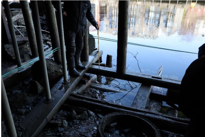
5. Nordbrygga. Nyere kreosotstokker fjernes.
