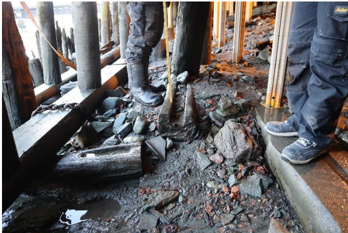
15. Midtbrygga. Reetablere bunnstokk 3 som er fjernet. Det legges ny bindebjelke.
