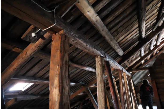
Takkonstruksjon over nordbrygga.
