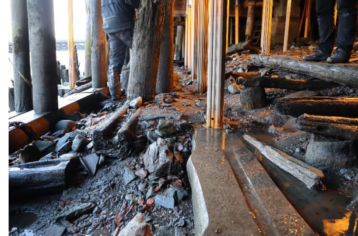
16. Midtbrygga. Nylagt bunnstokk 4. Det legges ny bindebjelke.
