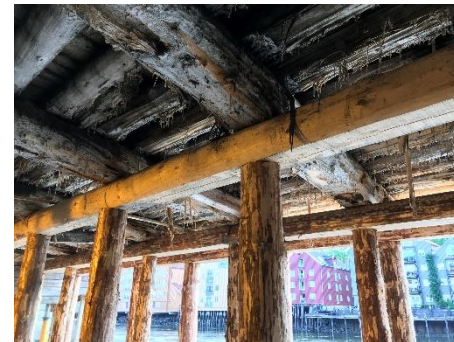
Midtbrygga: Konstruksjonsprinsipp
