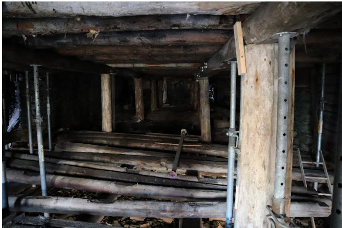
27. Sørbrygga. Reetablerer dragere og stolperække etter spor.
