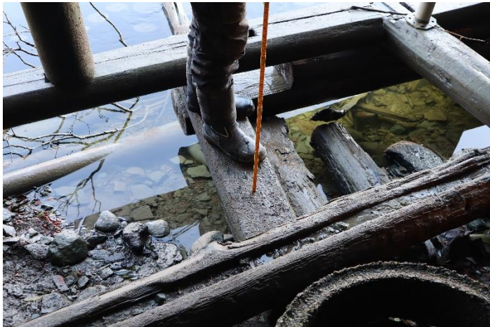
6. Nordbrygga. Nyere kreosotstokker fjernes.
