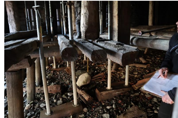
25. Sørbrygga. Eksisterende bunnstokk og stolperække fjernes.
