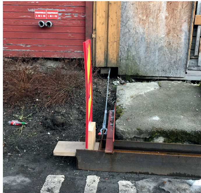
Foto viser fasaden mot Kjøpmannsgata og betongstøpen inn mot fasadelivet og nordvestre hjørne.
