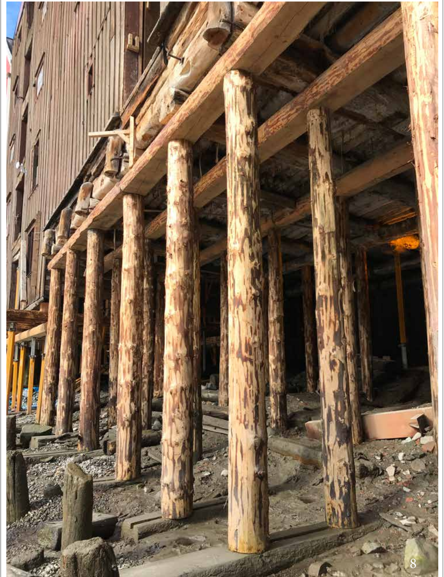
Istandsatt konstruksjonen under midtbrygga. Foto: 10.06.2020.
