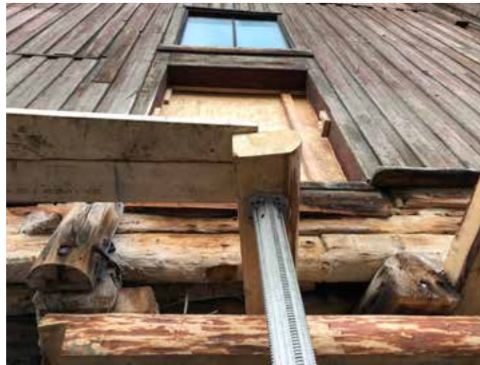
Hoveddrager under kaia ligger ann på bindebjelken som ses nederst i bildet over.
