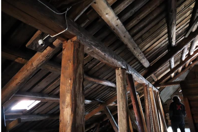
Takkonstruksjon over nordbrygga.
