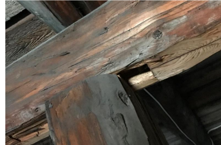
Takkonstruksjon over nordbrygga.
