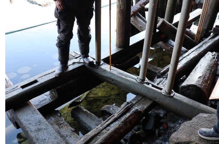
7. Nordbrygga. Nyere kreosotstokker fjernes.
