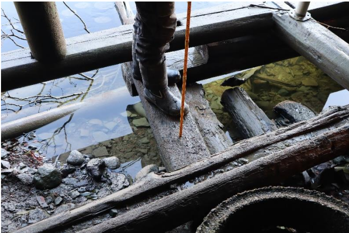
6. Nordbrygga. Nyere kreosotstokker fjernes.
