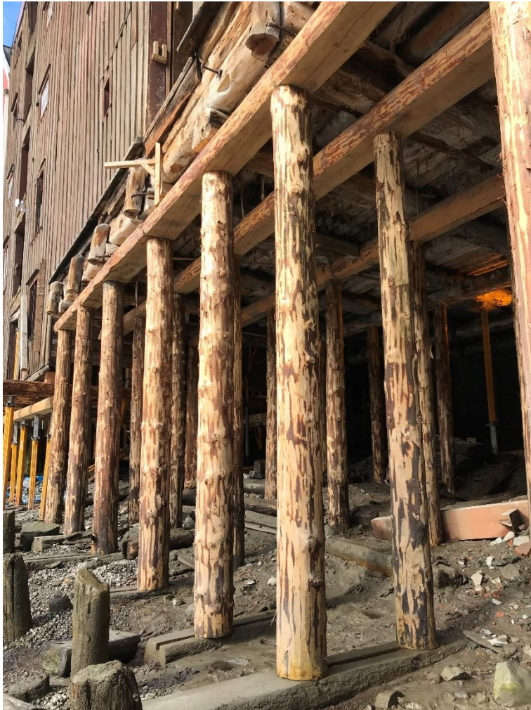
Ferdig bæring under midtbrygga.
