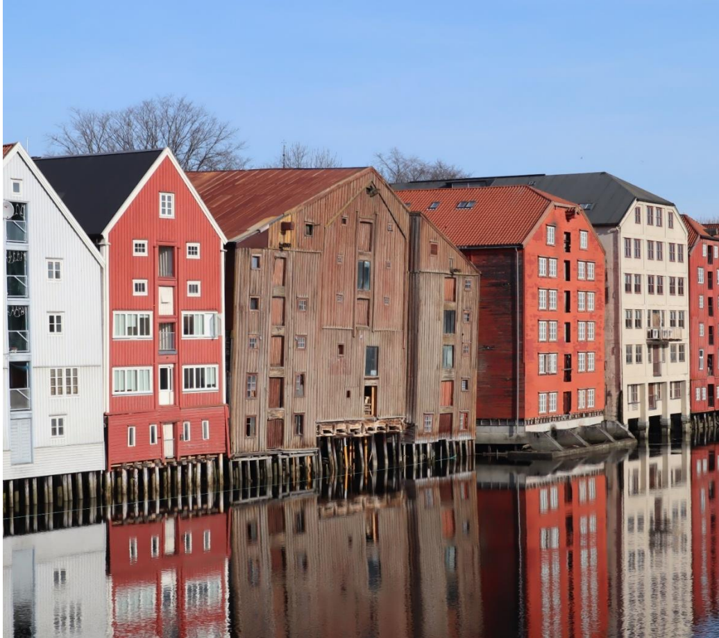
Brygga før og etter jekking.
