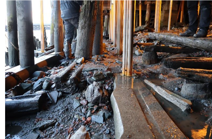
16. Midtbrygga. Nylagt bunnstokk 4. Det legges ny bindebjelke.
