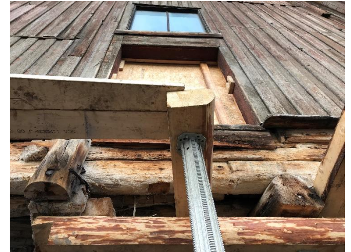
Ferdig bæring under midtbrygga. Foto: 16.10.19
