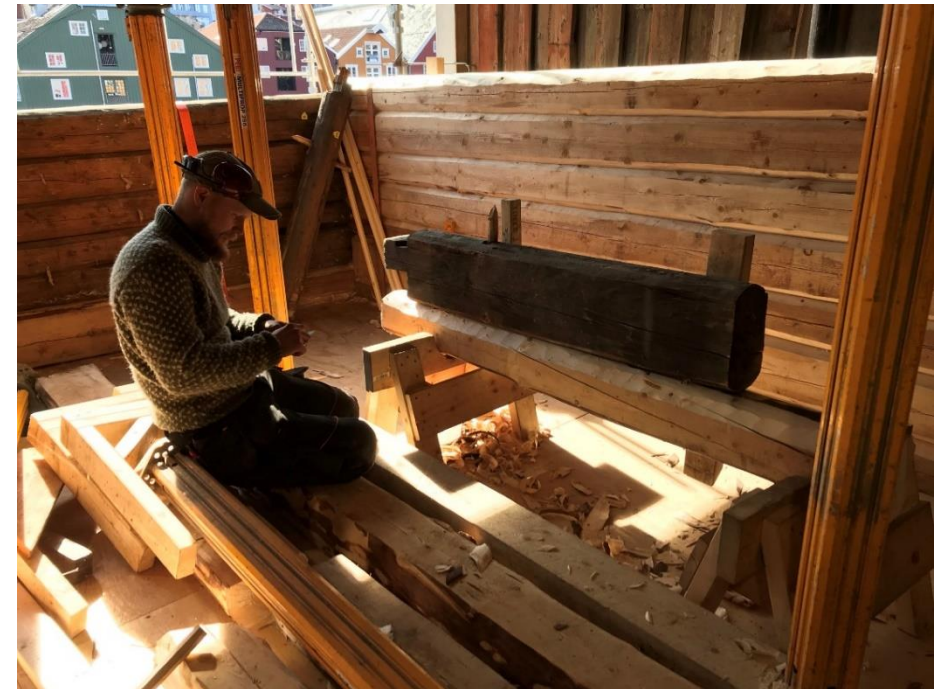
Foto: sørbrygga, 2. etasje, 06.05.21
