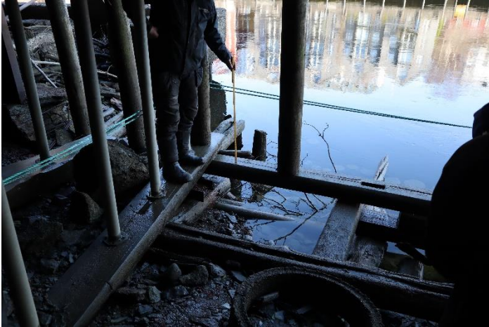
5. Nordbrygga. Nyere kreosotstokker fjernes.
