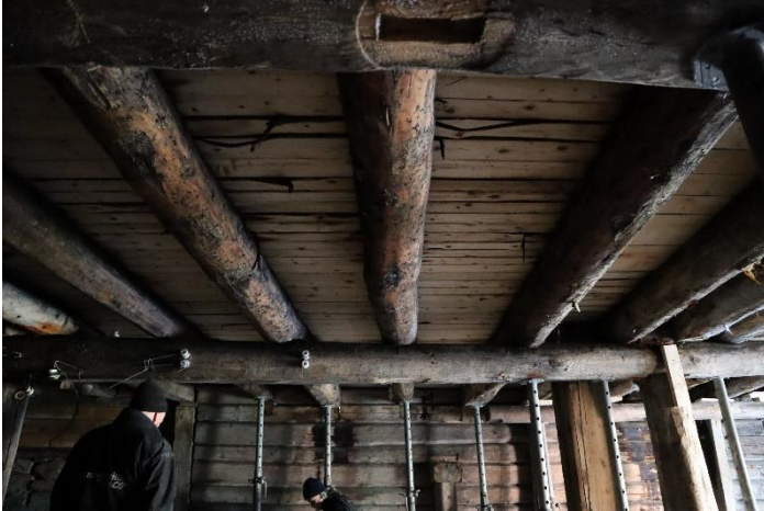
26. Sørbrygga. Reetablerer dragere og stolper etter spor.
