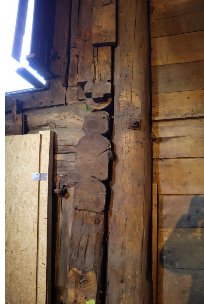
26. Sørbrygga. Reetablerer dragere og stolper etter spor.
