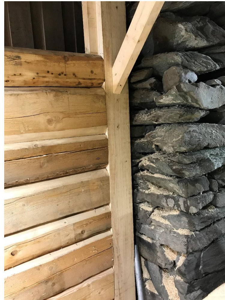
Foto: sørbrygga, underetasje, 04.11.20
