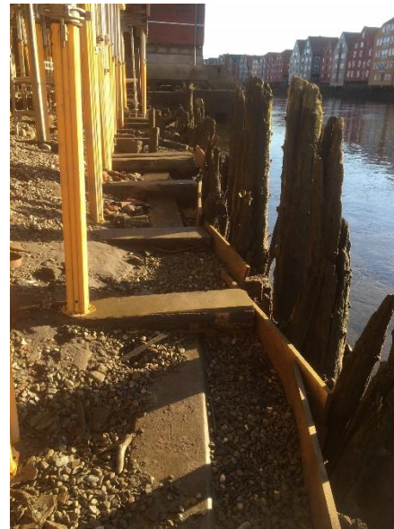
Bunnbindebjelker og eksisterende pallisade.
