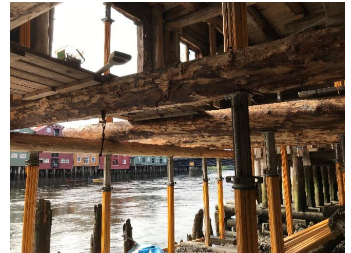
Sørbrygga under arbeid. Foto: 10.06.20
