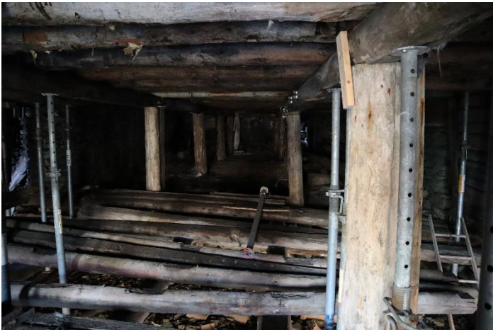
27. Sørbrygga. Reetablerer dragere og stolper etter spor.
