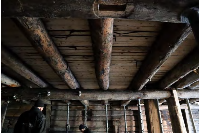
26. Sørbrygga. Reetablerer dragere og stolperække etter spor.
