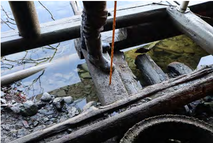
6. Nordbrygga. Nyere kreosotstokker fjernes.
