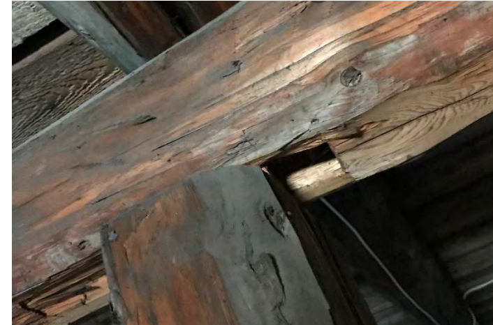
Takkonstruksjon over nordbrygga.
