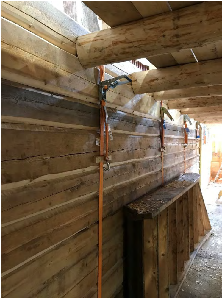
Foto sørbrygga, 1. etasje, 28.04.2021
