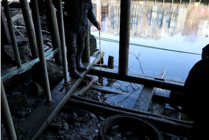
5. Nordbrygga. Nyere kreosotstokker fjernes.
