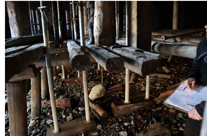
25. Sørbrygga. Eksisterende bunnstokk og stolperække fjernes.
