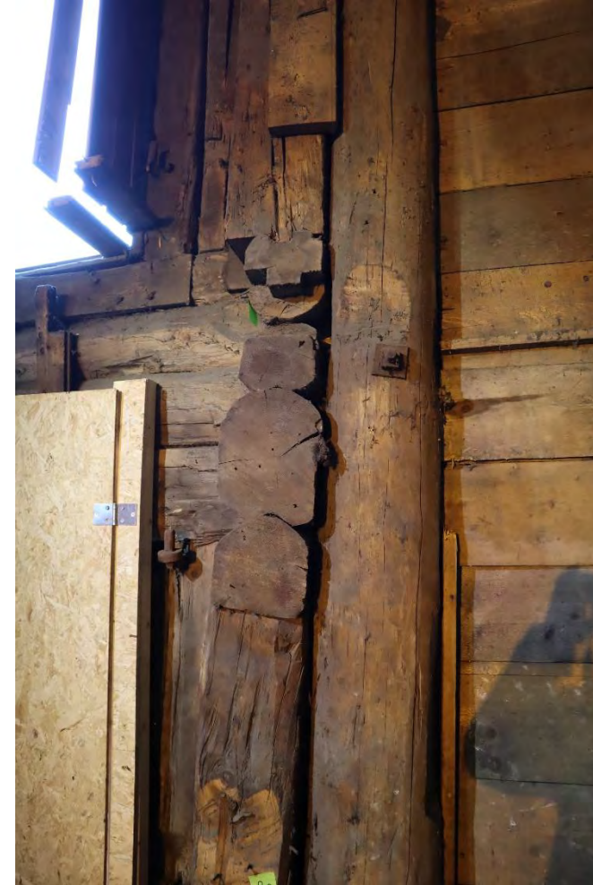
27. Sørbrygga. Reetablerer dragere og stolperække etter spor.
