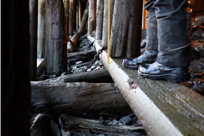
14. Midtbrygga. Kreosotstokk fjernes langs hele brygga. Denne ligger utenfor systemet.
