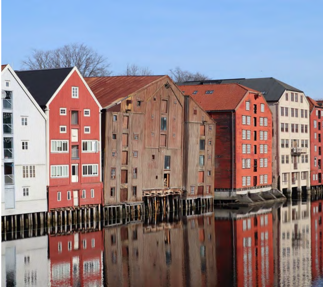
Brygga før og etter jekking.
