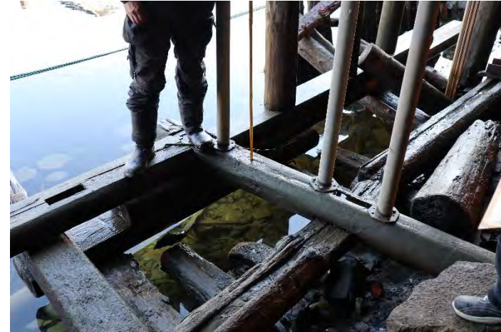
7. Nordbrygga. Nyere kreosotstokker fjernes.
