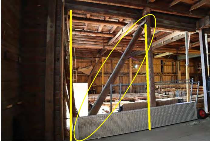
Midtbrygga. Strever yttervegg mot nord.
