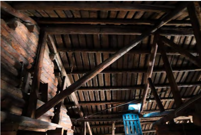
Takkonstruksjon over midtbrygga.
