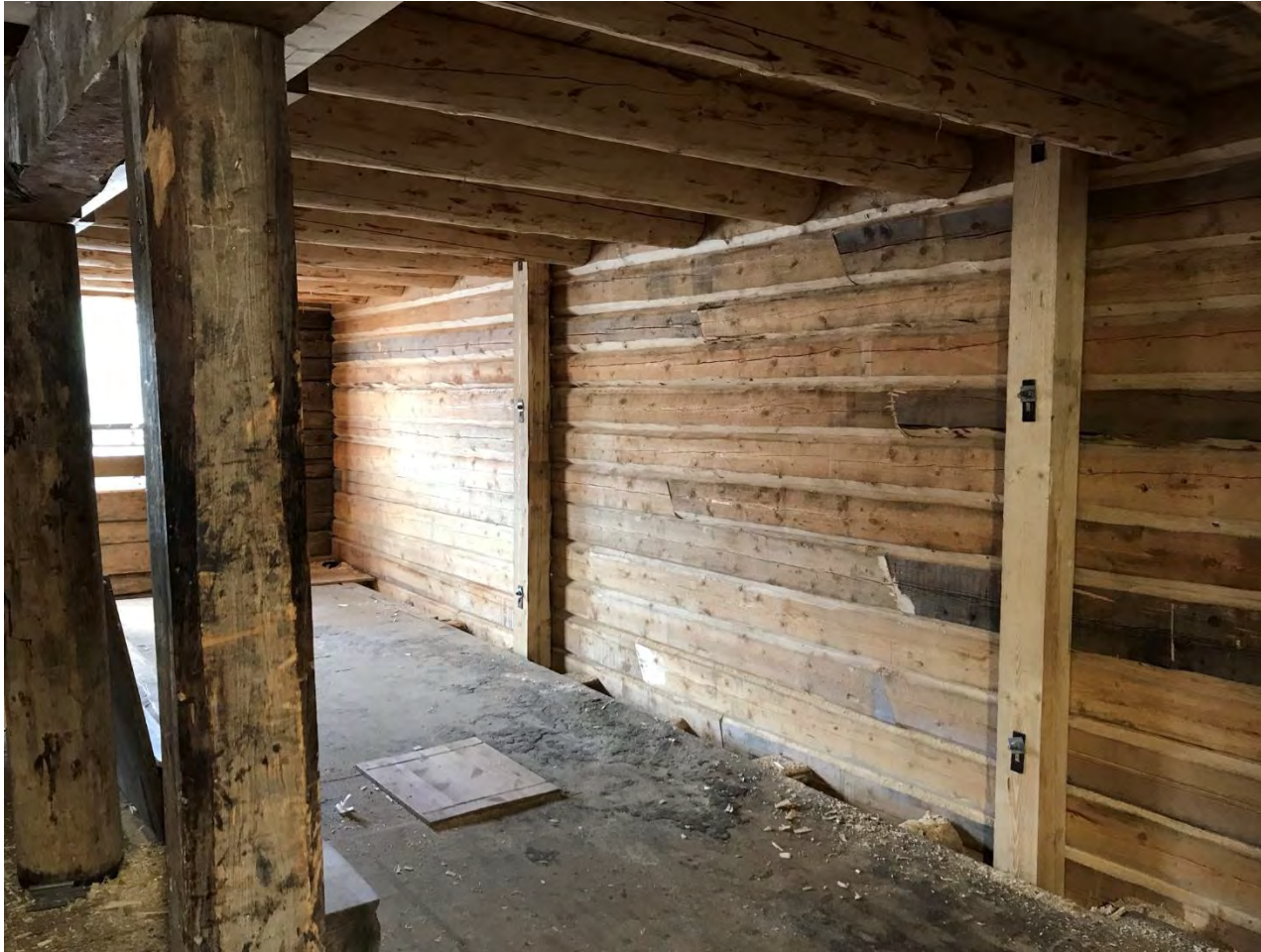
Foto: Sørbrygga, 2. etasje, 11.08.21
