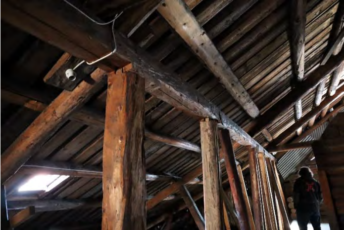
Takkonstruksjon over nordbrygga.
