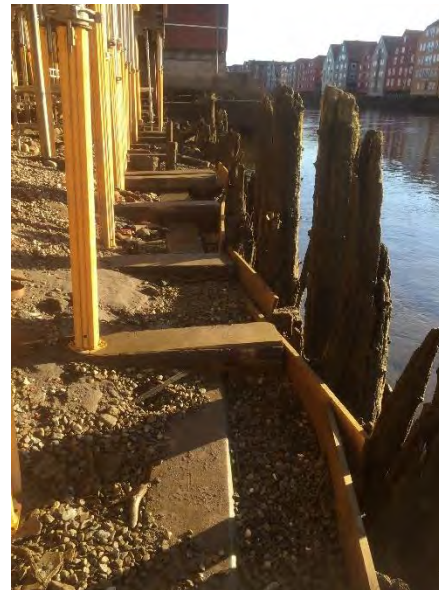
Bunnbindebjelker og eksisterende pallisade.
