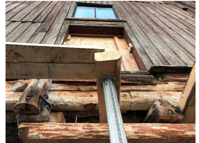
Ferdig bæring under midtbrygga. Foto: 16.10.19
