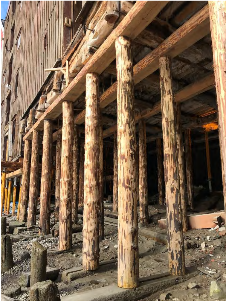
Ferdig bæring under midtbrygga.
