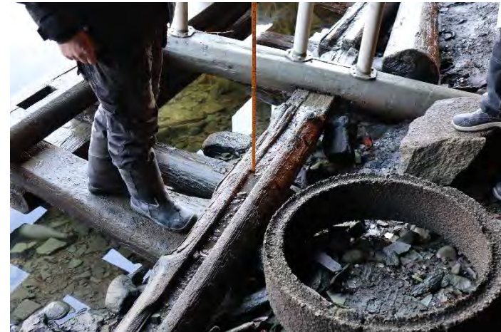
8. Nordbrygga. Gjenbrukt bunnstokk som ligger over kreosotstokken fjernes.
