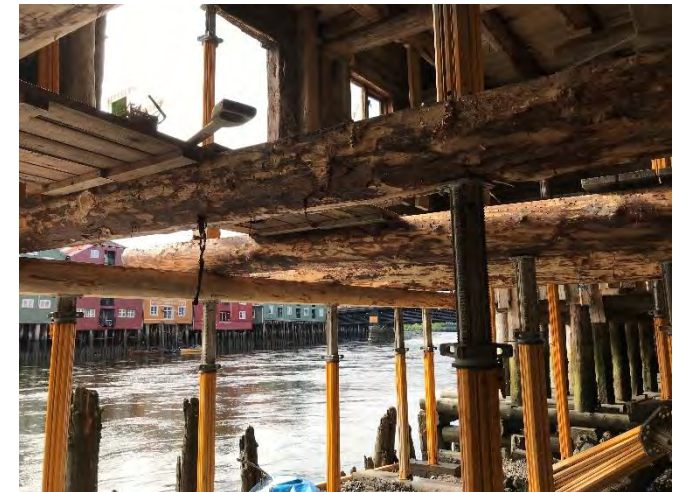
Sørbrygga under arbeid. Foto: 10.06.20
