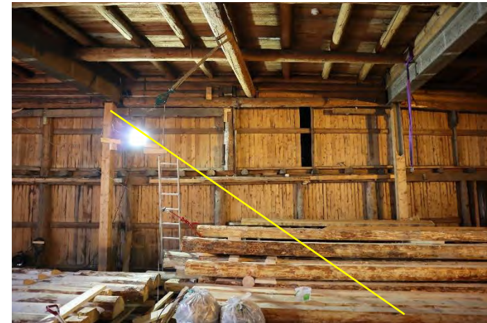
Midtbrygga. Mot sør Stålkjerne forsterkes med wire, merket med gult.
