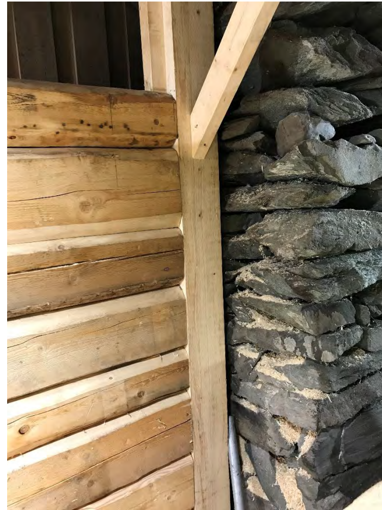
Foto: sørbrygga, underetasje, 04.11.20
