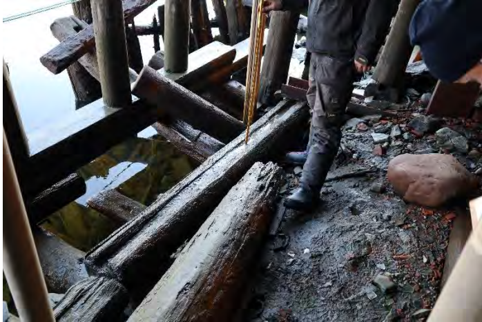
9. Nordbrygga. Gjenbrukt bunnstokk som ligger over kreosotstokken fjernes.
