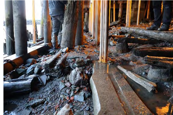
16. Midtbrygga. Nylagt bunnstokk 4. Det legges ny bindebjelke.
