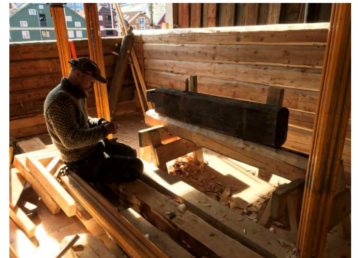
Foto: Sørbrygga, 2. etasje, 06.05.21
