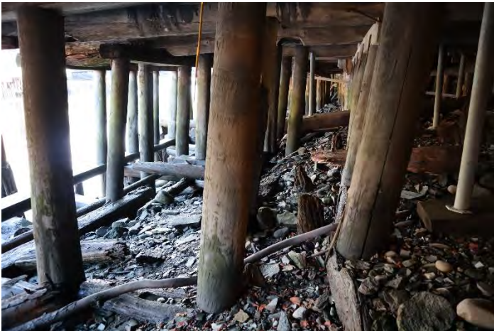
23. Sørbrygga. Det legges ny bunnstokk 4.
