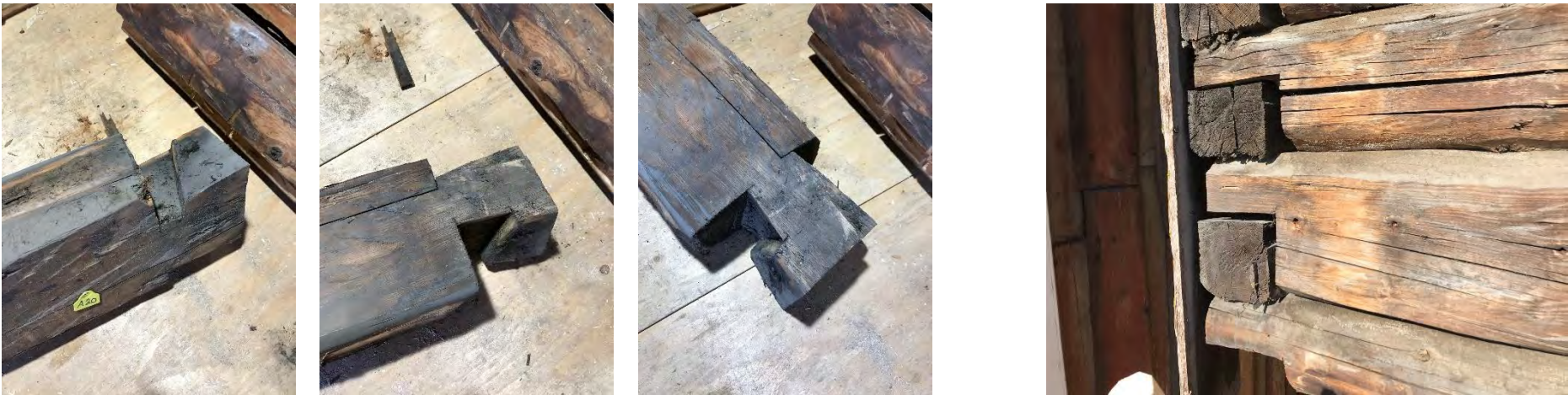
Sørbrygga vest og utvendig hjørne mot øst, 3. etasje. Foto: 06.05.2021.
