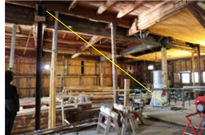
Midtbrygga. Mot Nord Stålkjernen forsterkes med wire, merket med gult.
