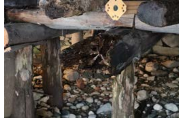
11 og 12. Nordbrygga. Bunnstokk 4, 5 og 6 reetableres i henhold til spor i drager.
