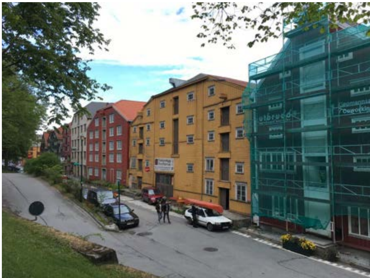
Fasaden mot Kjøpmannsgata. Foto: 21.06 2018 og 15.11.22
