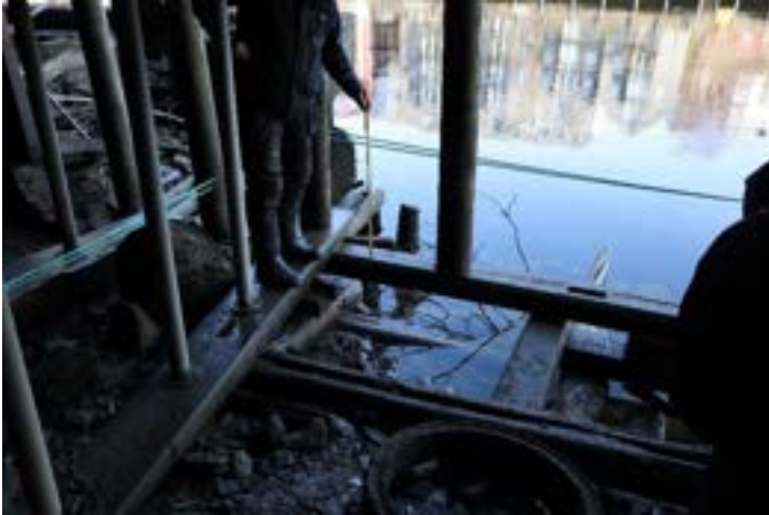
5. Nordbrygga. Nyere kreosotstokker fjernes.
