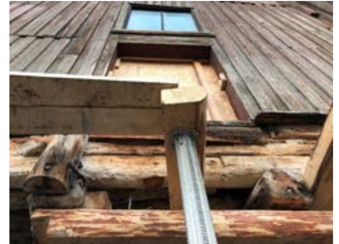
Ferdig bæring under midtbrygga. Foto: 16.10.19
