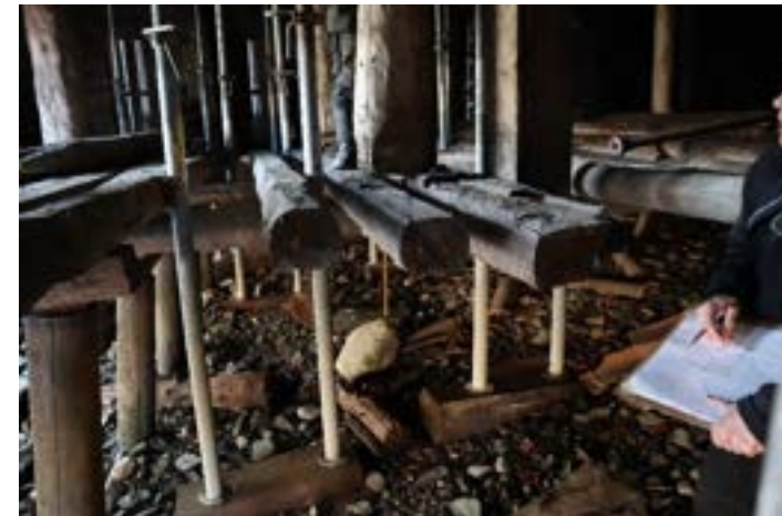
25. Sørbrygga. Eksisterende bunnstokk og stolperække fjernes.
