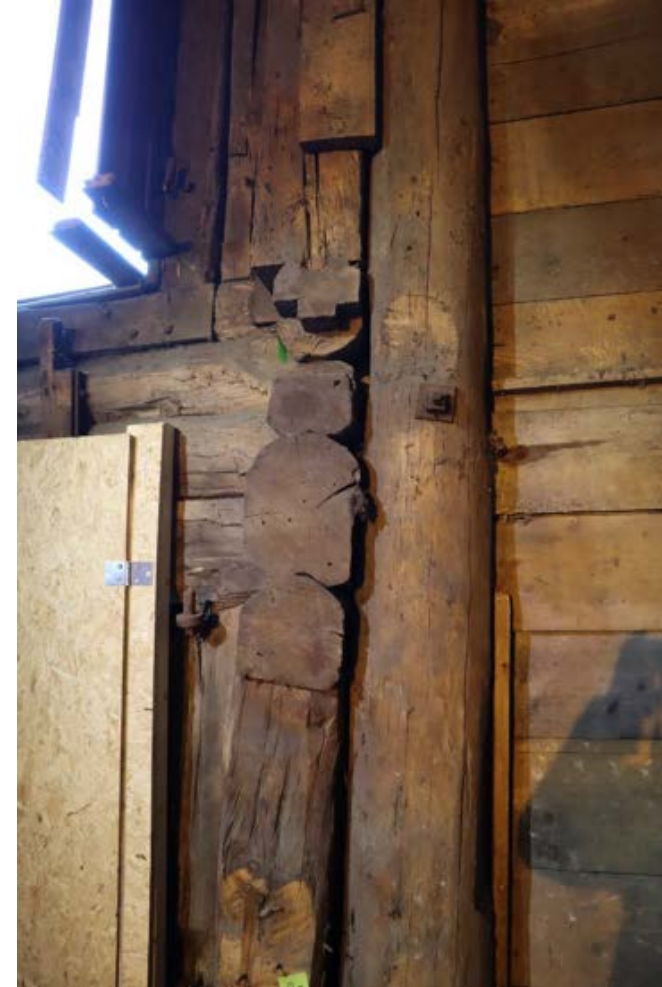
26. Sørbrygga. Reetablerer dragere og stolperække etter spor.
