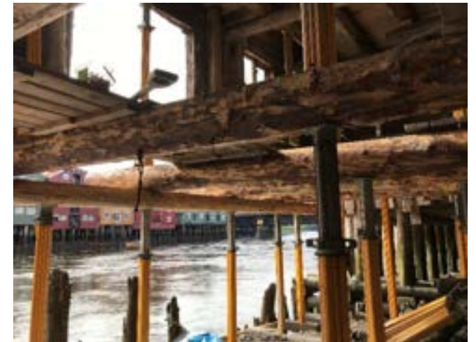
Sørbrygga under arbeid. Foto: 10.06.20
