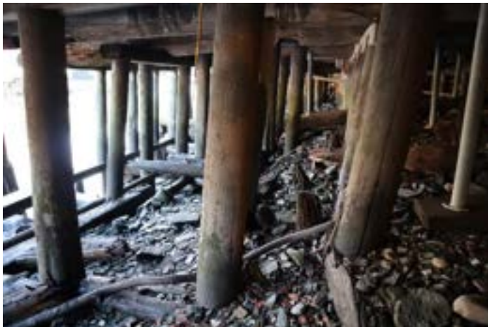
23. Sørbrygga. Det legges ny bunnstokk 4.
