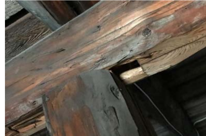
Takkonstruksjon over nordbrygga.
