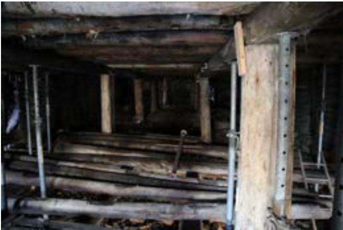
27. Sørbrygga. Reetablerer dragere og stolperække etter spor.
