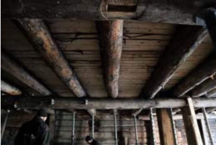
26. Sørbrygga. Reetablerer dragere og stolperække etter spor.
