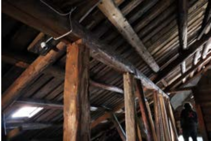
Takkonstruksjon over nordbrygga.
