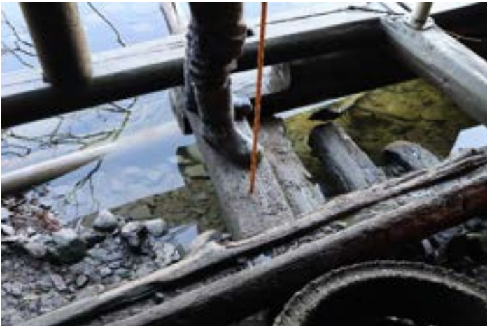
6. Nordbrygga. Nyere kreosotstokker fjernes.
