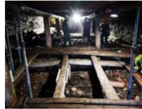
Sør- og nordbrygga: Konstruksjonsprinsipp
