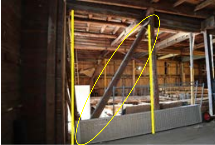
Midtbrygga. Strever yttervegg mot nord.
