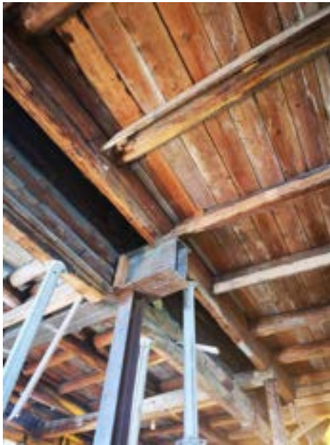
Nordbrygga hviler på ståldrager til øst i 1. etg.
