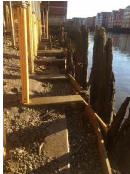
Bunnbindebjelker og eksisterende pallisade.
