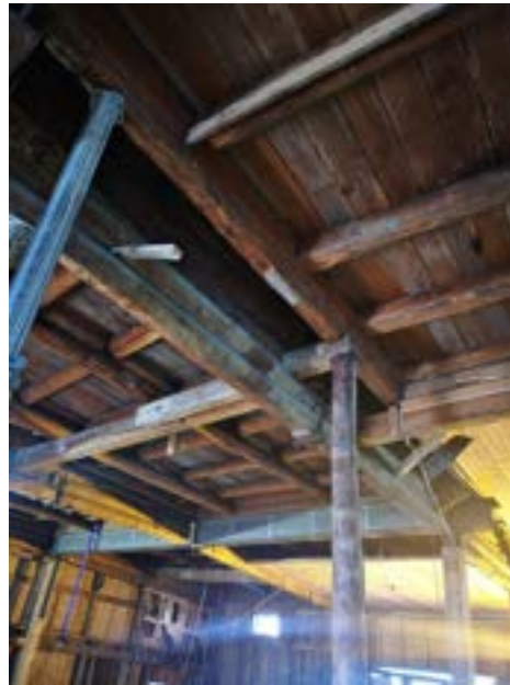
Eksempel på bjelke som er i mellom bryggene. 1. etg.
