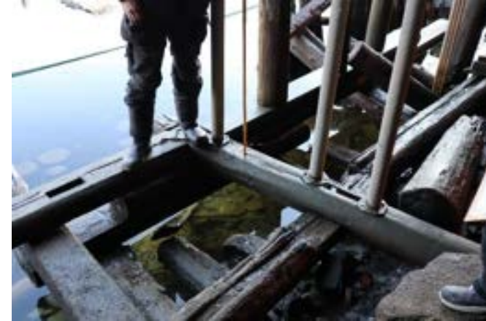
7. Nordbrygga. Nyere kreosotstokker fjernes.
