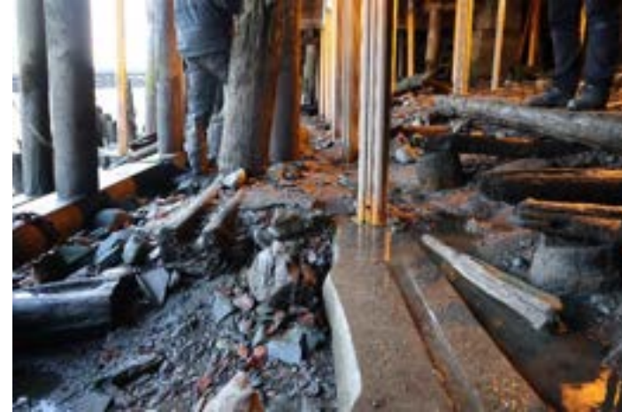
16. Midtbrygga. Nylagt bunnstokk 4. Det legges ny bindebjelke.
