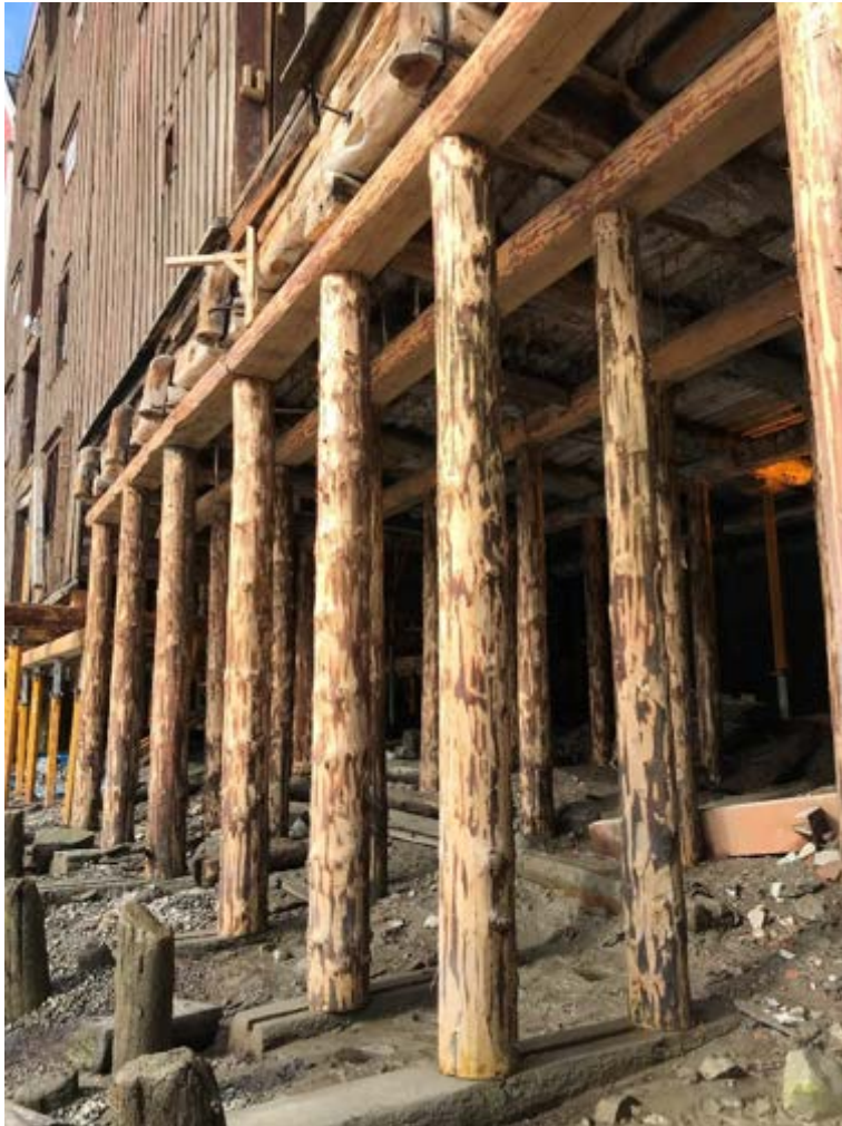
Ferdig bæring under midtbrygga.
